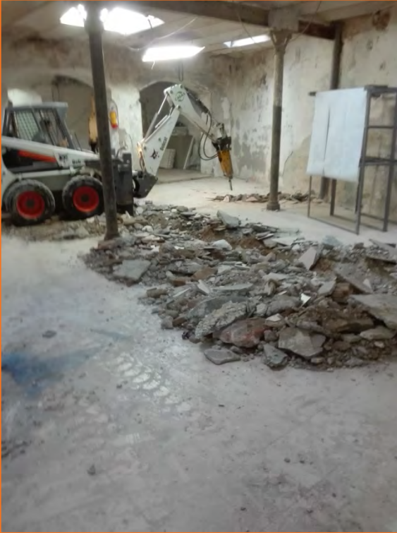
Foto 23. Vista de l'inici dels treballs a la Rasa 5.
