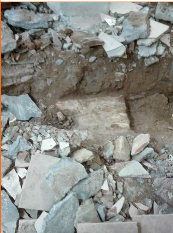
Foto 12. Vista de la riostra UE 105.
