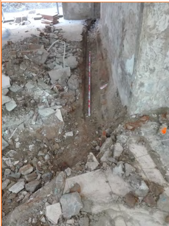
Foto 16. Vista general del primer tram de la Rasa 2.
