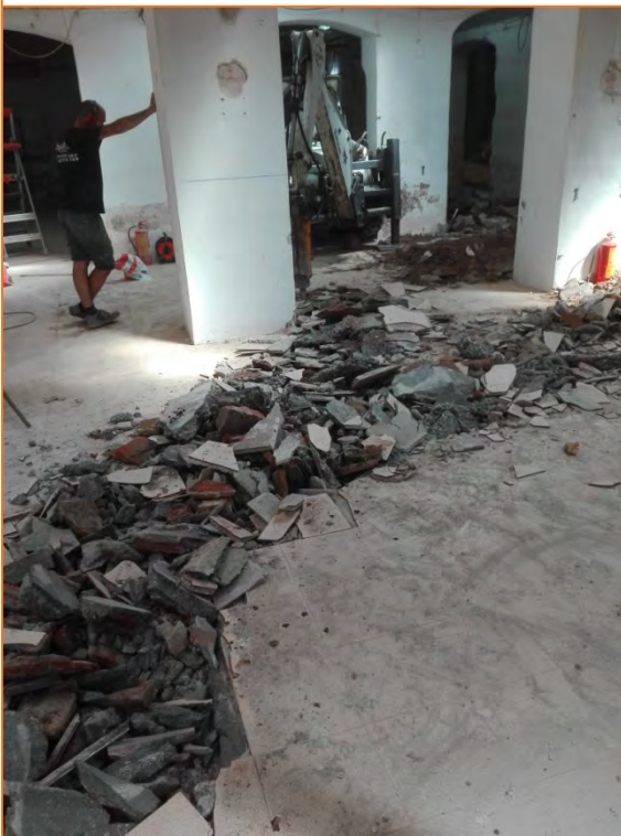
Foto 20. Vista de l'inici dels treballs a la Rasa 4.
