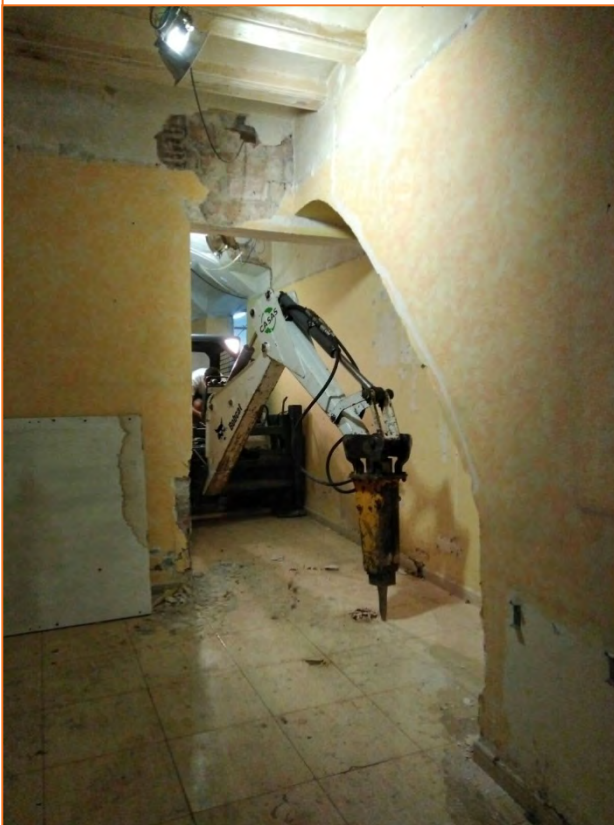
Foto 4. Vista de l'inici dels treballs a la Rasa 1.
