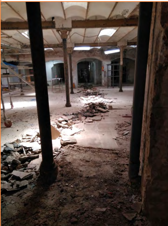
Foto 8. Vista dels treballs del picat del terra actual UE 101 per realitzar la Rasa 1.
