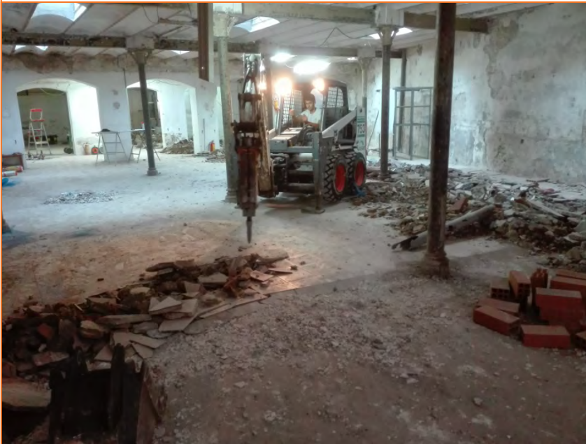
Foto 15. Vista de l'inici dels treballs a la Rasa 2.
