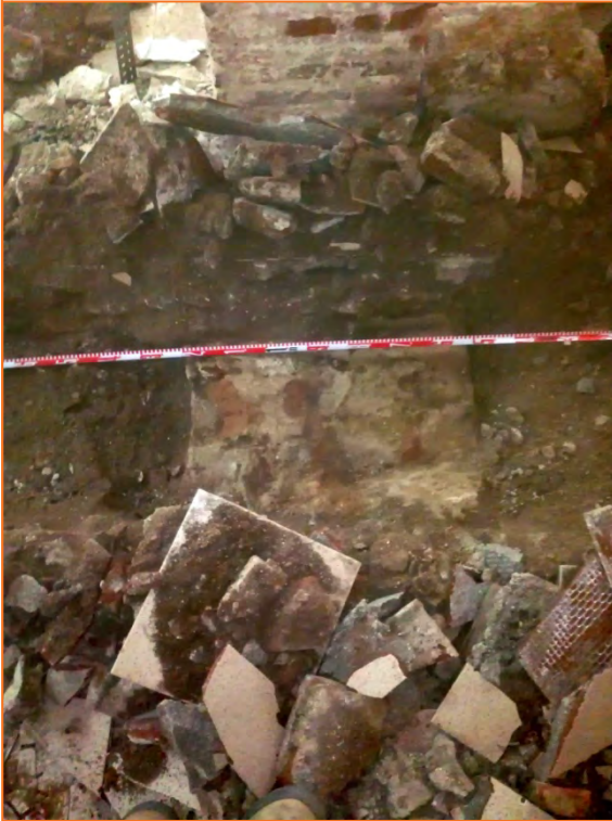
Foto 27. Vista de la riostra UE 108.
