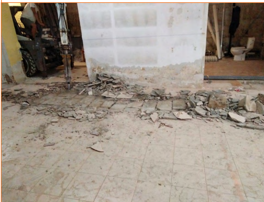
Foto 6. Vista de situació del paviment UE 102.
